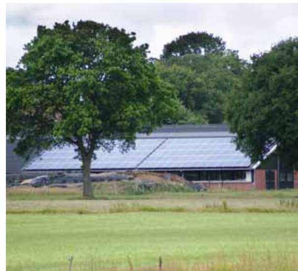
Zonnecellen op het dak van een bedrijfsgebouw zijn rendabel, maar Kiemkracht kijkt nog een stapje verder om meerwaarde te creëren.
